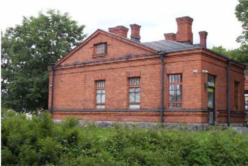
36E Puhelinkeskukseksi nimetty rakennus vuodelta 1914.
